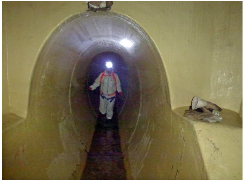
handlaminiertes Schacht in der Sanierungsstrecke
