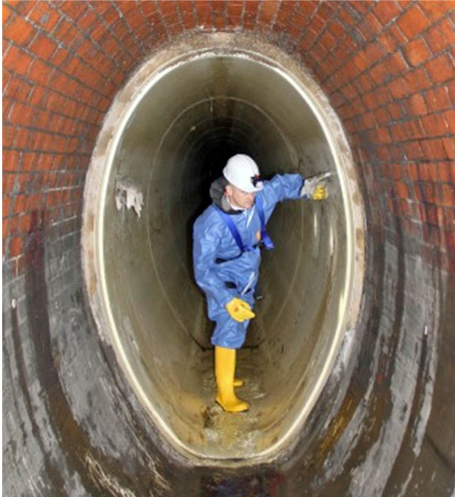
Der erste Sanierungsabschnitt ist fertig verdammt
